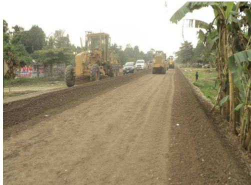
Inicio de la Obra
