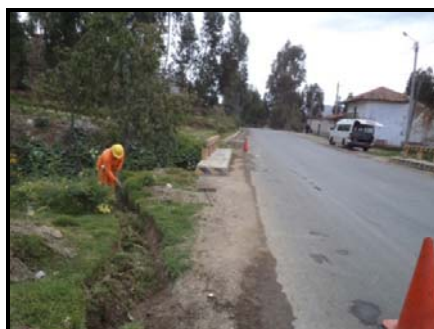
Limpieza de cunetas no revestidas
