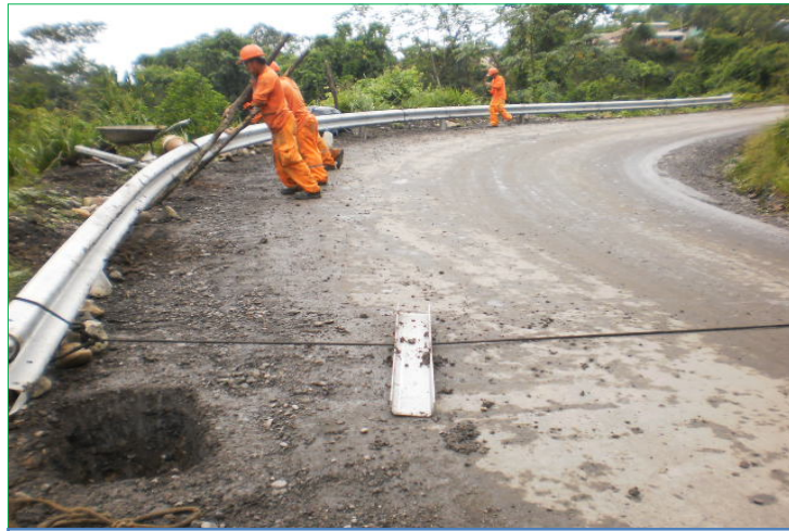
Foto 14: Colocación de Guardavías. Tramo V Km 40+200 (PE 028C)
